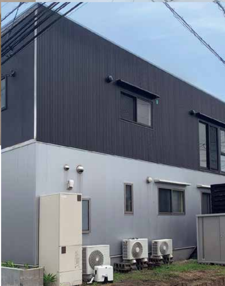
△AFTER 外壁・屋根塗装と板金工事をし、新築のときを思い出す仕上がりでカッコいい家に。
